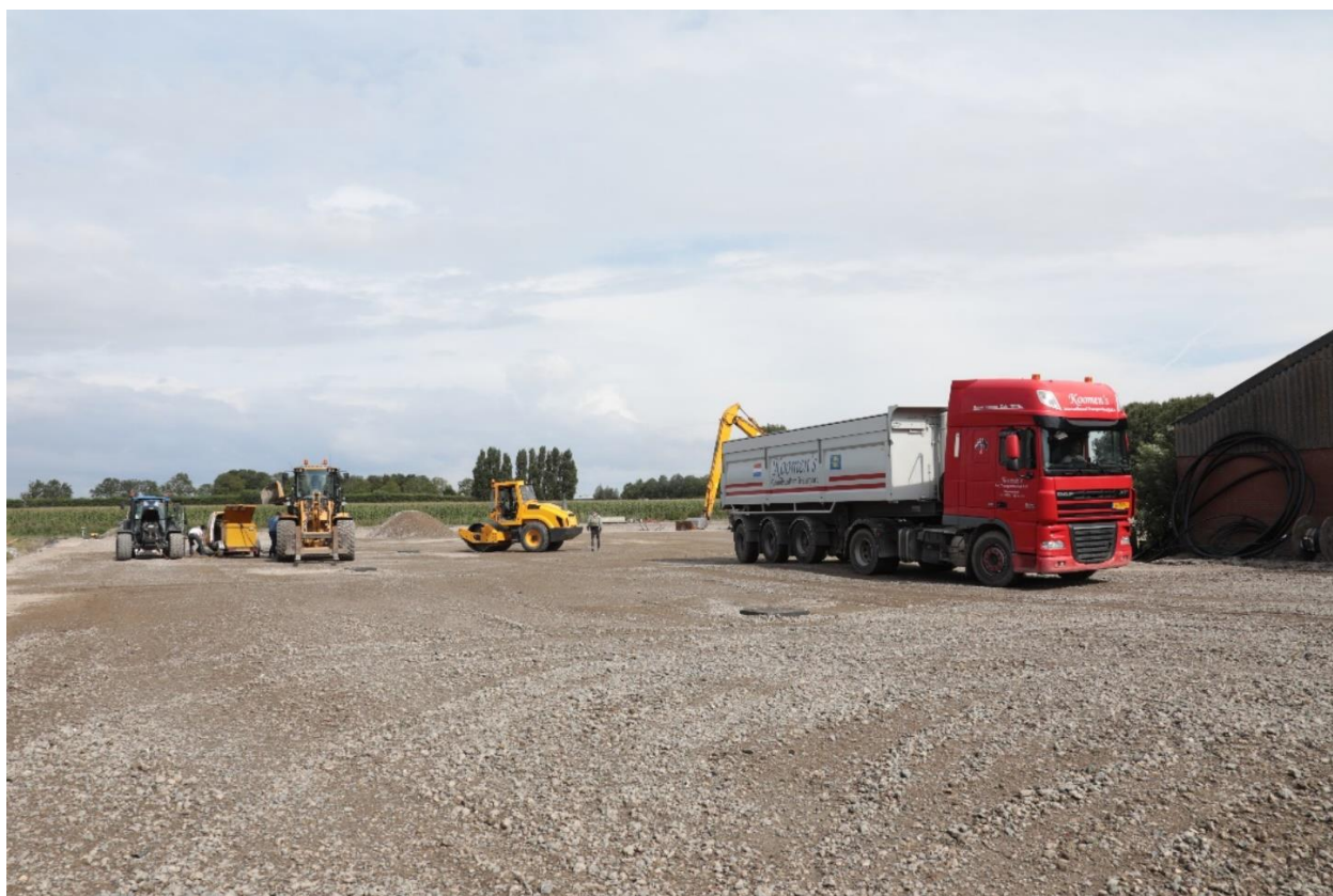
Het aanbrengen van puingranulaat als verharding.
