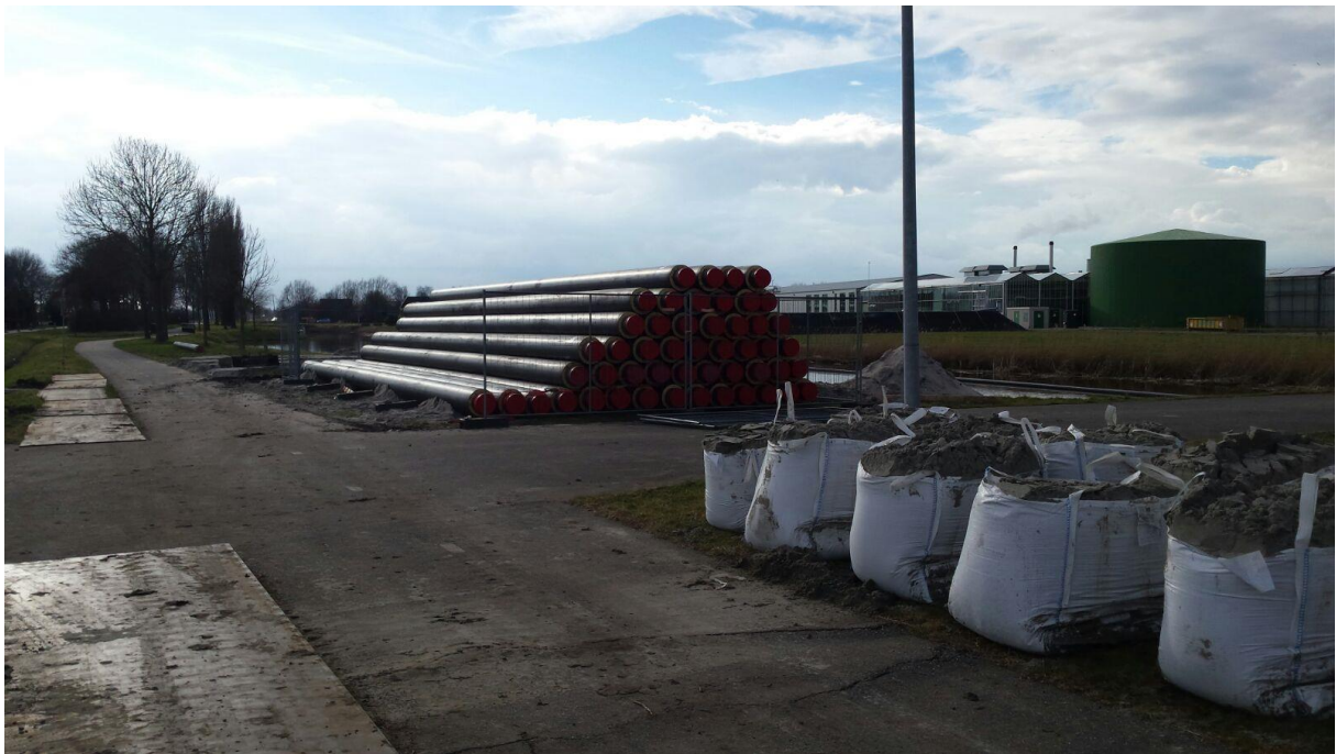
Geïsoleerde leidingen voor het transport van het water liggen klaar om in de grond te worden gelegd (Foto's Klaas Jan Weel).
