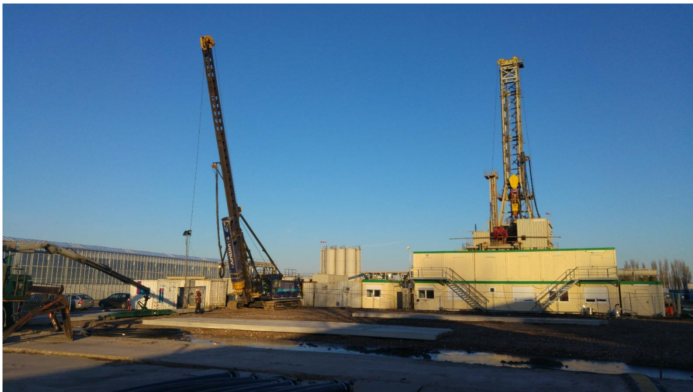
De heipalen voor de fundering van de vloer van de geocentrale worden geheid.
