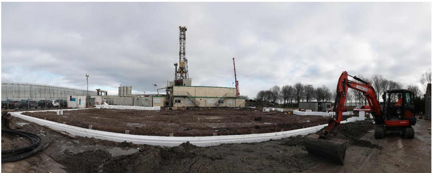
De bekisting voor het storten van de fundering wordt aangelegd. (Foto Kenneth Stamp).
