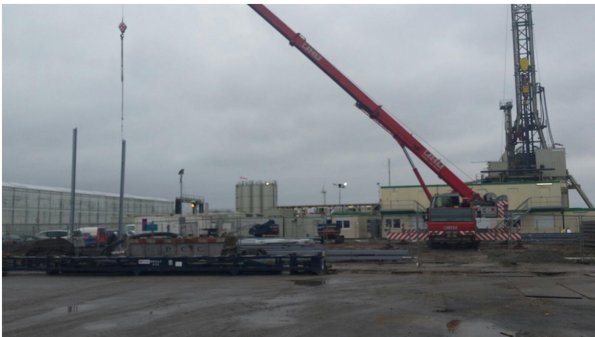
De eerste stalen spanten van de geocentrale worden geplaatst. (Foto Klaas Jan Weel).
