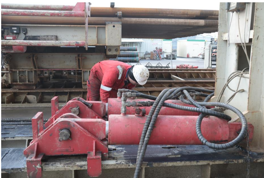
De vijzels die de boortoren van 450 ton over een slee naar voren trekken naar de volgende put (foto Kenneth Stamp).
